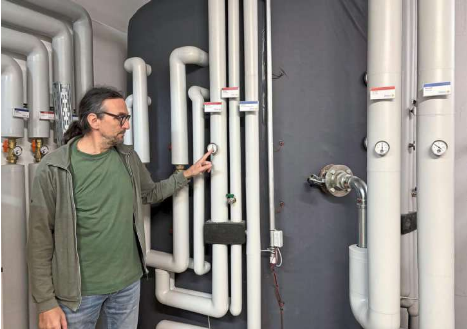
9.600 Liter fasst der Pufferspeicher der neuen Heizungsanlage der Kloster-Oase. Joachim Bär, Vorstandsvorsitzender der Genossenschaft, erklärt Funktion. Foto: Jörg Seiler
